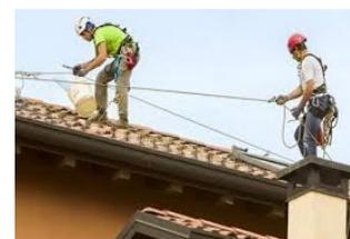
Quando i sistemi di protezione collettiva non si possono usare, utilizzare sistemi di ancoraggio che prevedano: un punto di ancoraggio certificato, una imbracatura anticaduta, un elemento di connessione (es. cordino tra ancoraggio e imbracatura), un sistema di discesa e recupero in caso di infortunio o malore.
