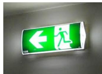
lo sgancio di emergenza. La normativa prevede delle verifiche e delle manutenzioni periodiche (ogni 6 mesi) per controllare lo stato di funzionamento ed individuare eventuali anomalie. Tra le verifiche periodiche sono comprese le verifiche di funzionamento e le verifiche di autonomia, ed entrambe devono essere effettuate da personale qualificato, in possesso di adeguata formazione di conoscenze specifiche della manutenzione elettrica.
